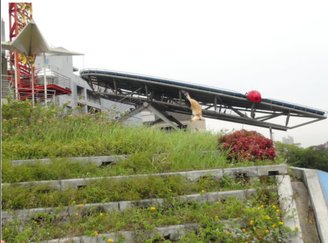
屋頂設有太陽能面板，利用太陽發電作為電力補助設施
